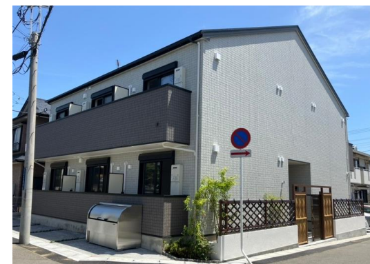
研修生用の寮25年5月完成
